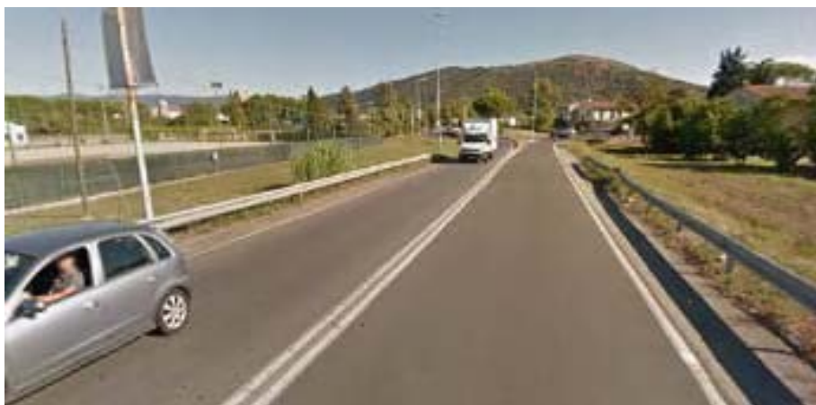
Foto 15 – S14 – Rampa nord verso Viale Marconi
