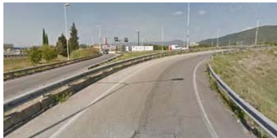
Foto 14 – S13 – Rampa sud verso Viale Marconi – direzione nord
