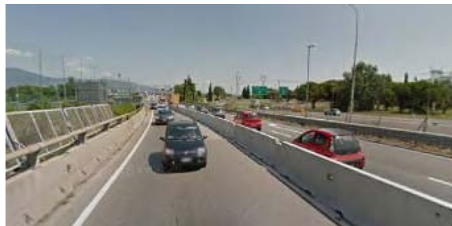
Foto 16 – S15 – Viale Leonardo da Vinci lato svincolo Prato Est
