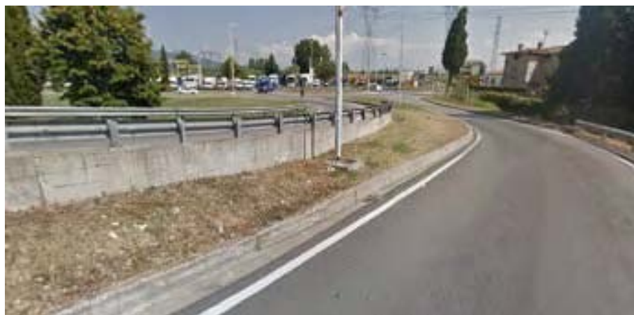
Foto 13 – S13 – Rampa sud verso Viale Marconi – direzione sud
