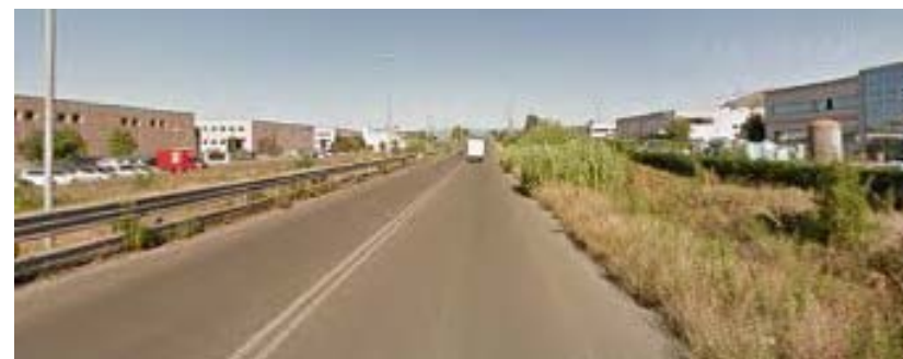
Foto 8 – S8 – Viale Leonardo da Vinci lato rotatoria via Allende / via Pratignone
