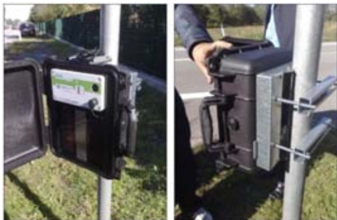
Figura 24 – RADAR SDR-Easydata – Esempio di installazione
