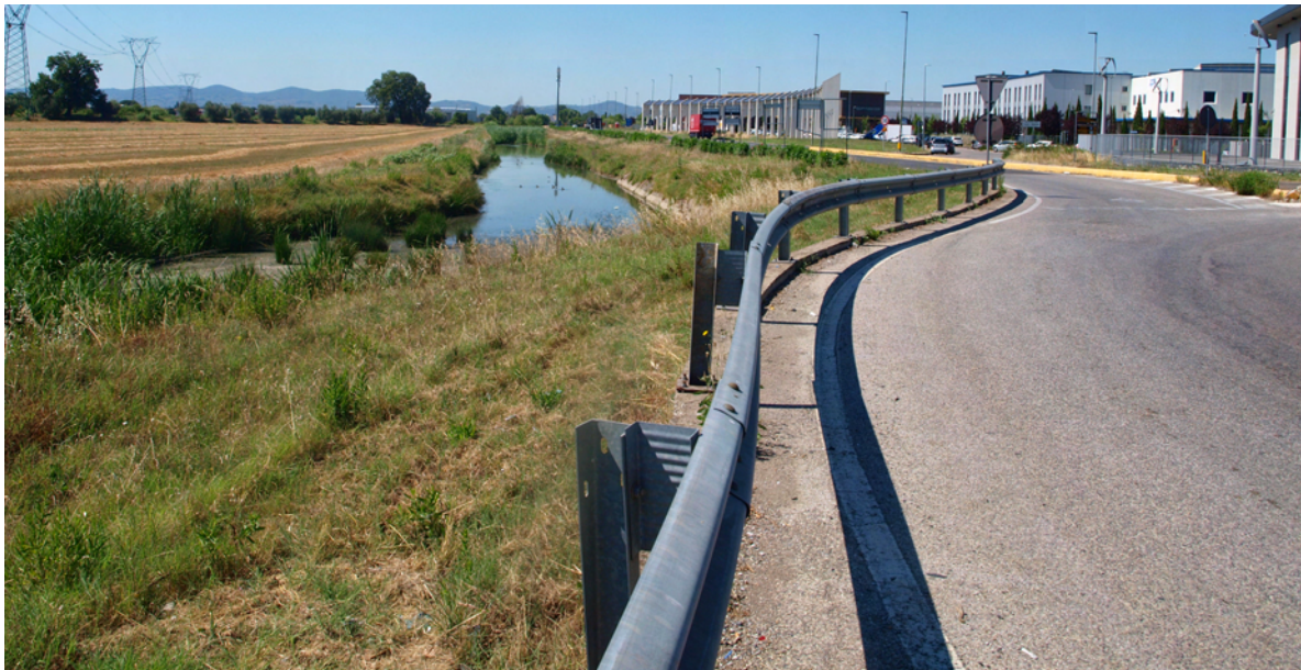
Fig. 6.24 – Guard Rail bi-onda esistente sul lato est della rotatoria
